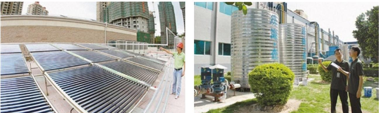
图3-25 珠海新建建筑太阳能热水系统（左）与地源热泵系统（右）
