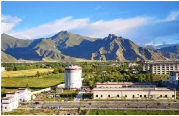
换热机房和储热钢罐
