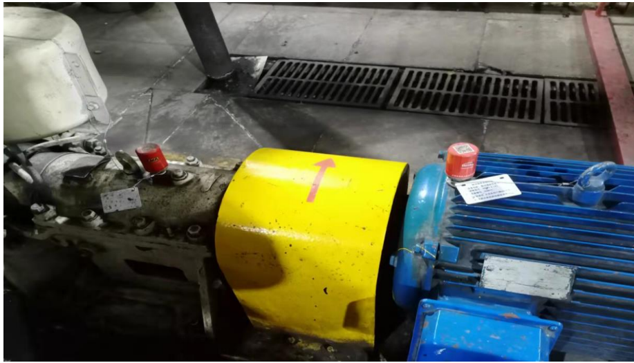
图 1 为无线温度振动传感器
