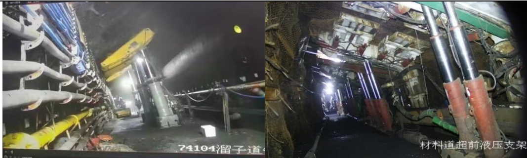
图 7 大倾角岩层直接顶梯形断面超前支架防护现场图
