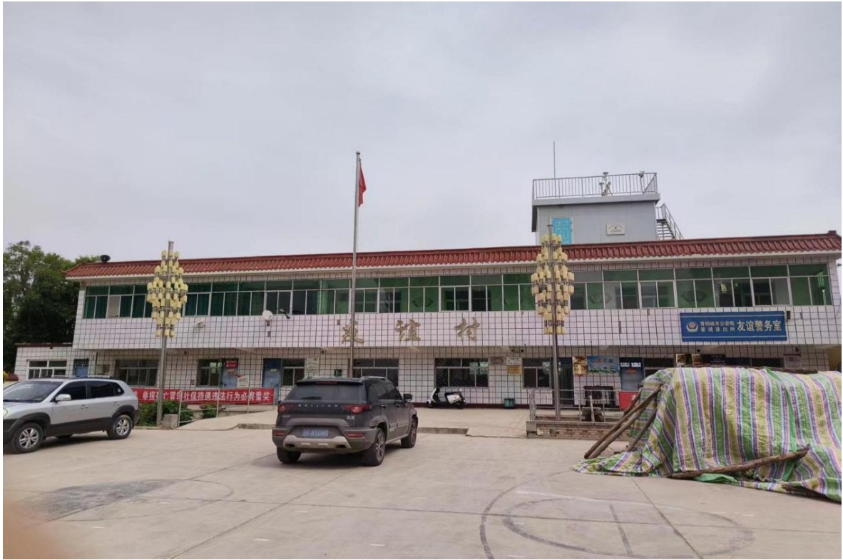
图 8 项目区农村地区公共建筑现状（三）
