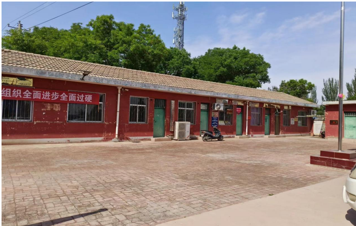
图 9 项目区农村地区公共建筑现状（四）
