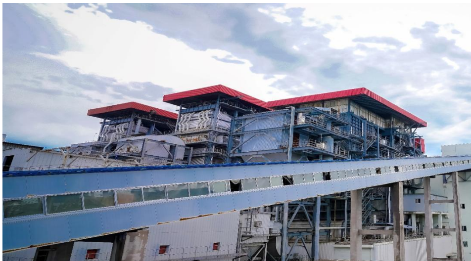
图 2 150t/h 生物质锅炉（最右）
