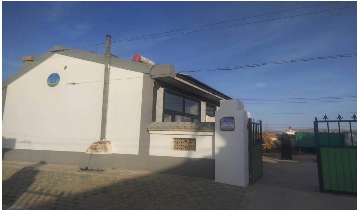
图 7 项目区农村居民住宅现状（二）
