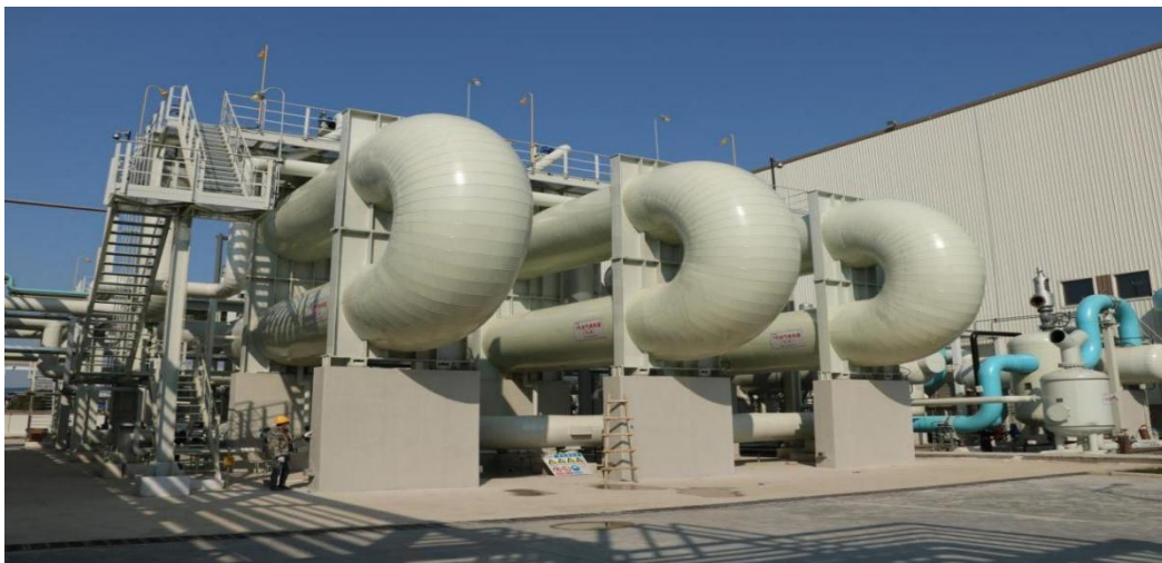
图4 发卡式油-空气换热器
