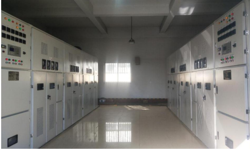
图 6 电网侧成套高可靠性并联补偿装置
