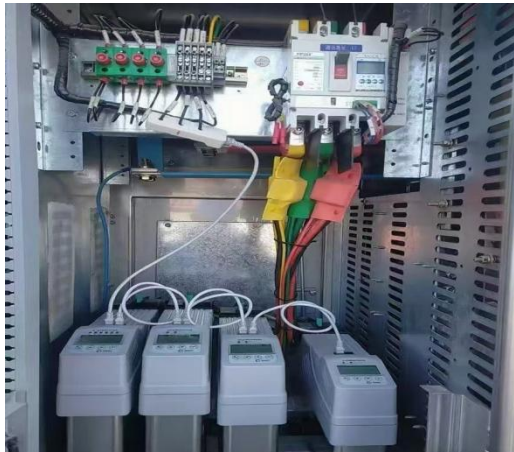
图 3-1 某台区低压无功补偿装置
