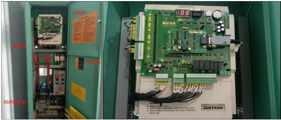
图 1 电梯控制柜内结构
