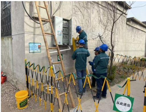
图 1-2 现场治理（压接下户线）
