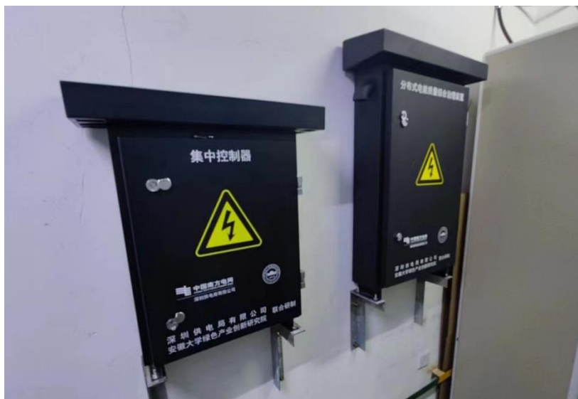
图 2 在园区配电房安装电能质量综合治理设备
