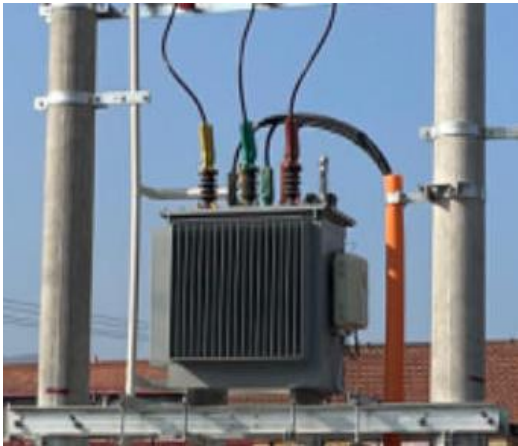
图 3-2 某台区有载调压变压器
