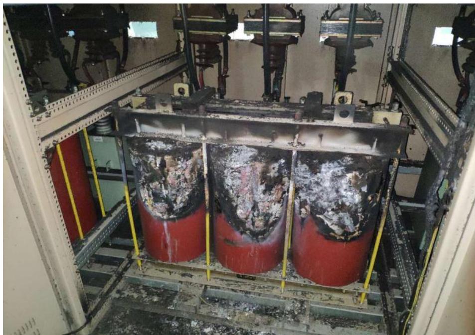
图 1 电容器组内电抗器损坏现场
