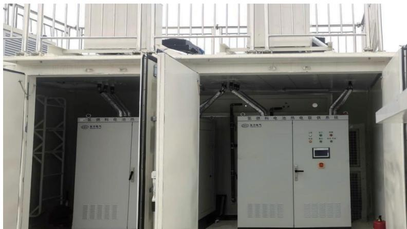
图 5 氢燃料电池热电联供系统
