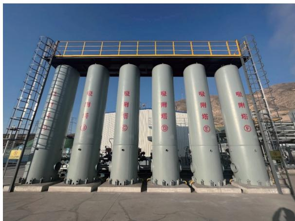
图 5 煤层气捕碳提氦制高纯氦（99.999%）工业装置
