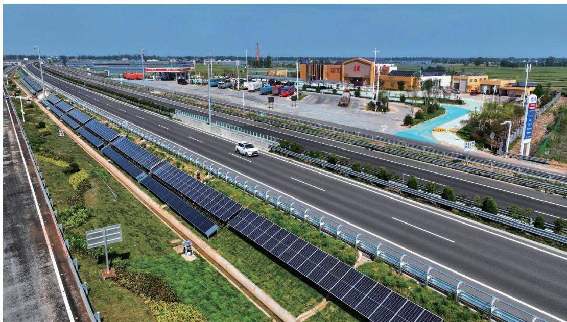
图 2 长线型边坡光伏
